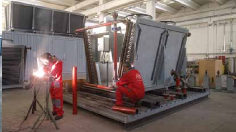
► realización conductos disipador de emergencia
