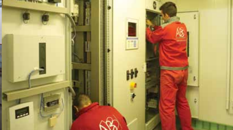
► realización cuadros eléctricos
