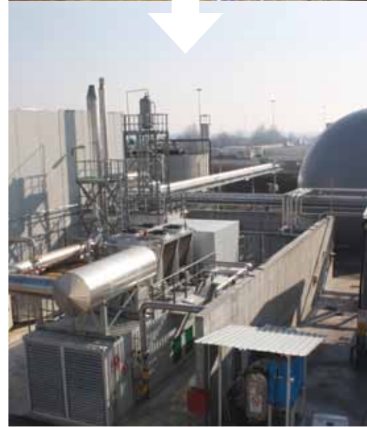
► biogás de residuos de los procesos de la industria alimentaria y de lodos de depuración
